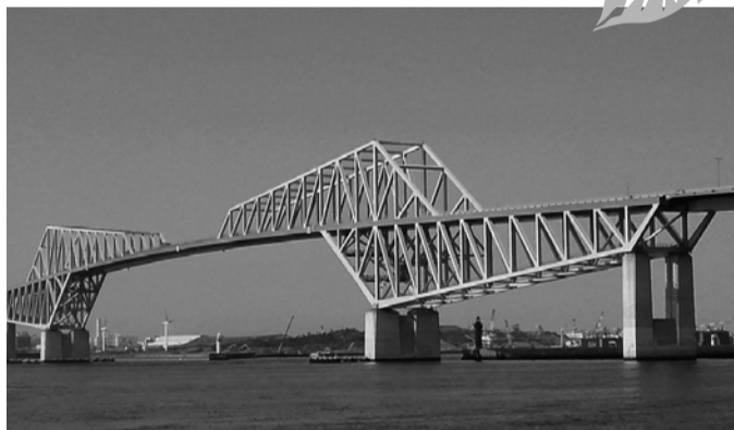
東京ゲートブリッジ
